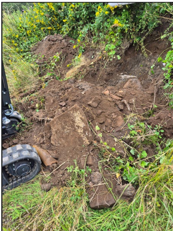
P25. Mulljord med inslag av sten. Större betongstycken och tegel.
