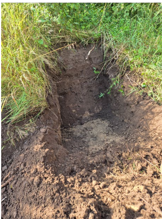
P 6. Mulljord med inslag av sten, någon betong och tegel samt en elkabel. Djup ca 1 m.
