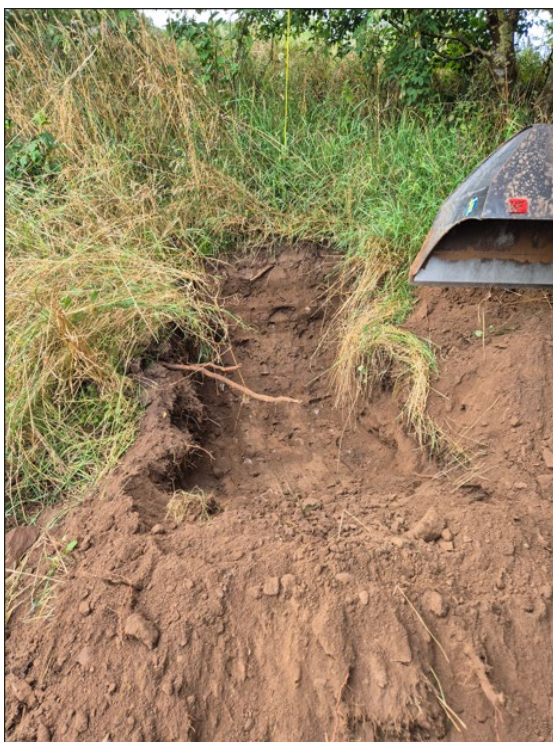
P31. Mulljord med inslag av mindre stenar och några asfaltbitar.
