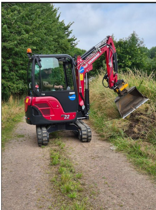
Bild 1 Använd grävare för provgropsgrävning.
