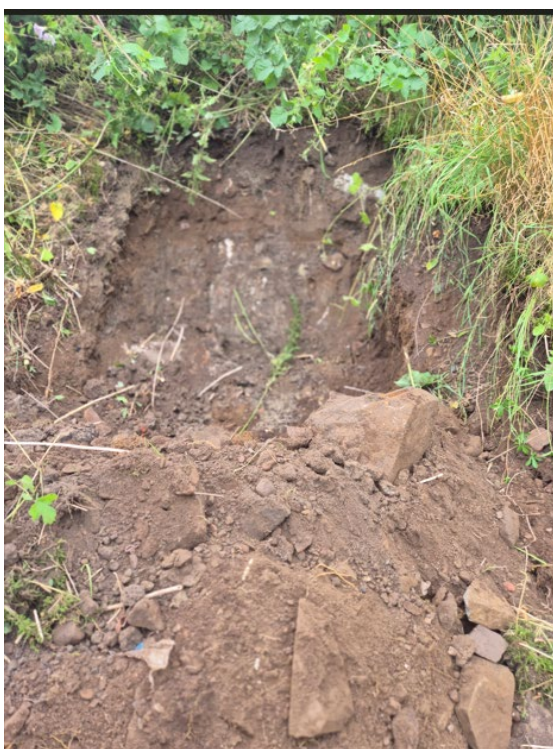
P24. Mulljord med inslag av mindre sten. Betong och tegel.
